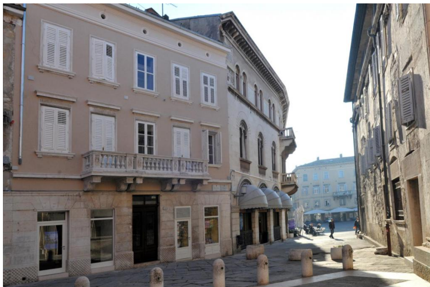
Slika 2 Primjer obnove fasade kroz projekt Dolcevita na Kapitolinskom trgu (Izvor: http://www.glasistre.hr/vijesti/pula_istra/nastavlja-se-projekt-dolcevita-470028 )
