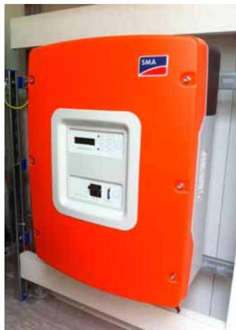
Slika 17, Sunny Backup baterijski inverter
